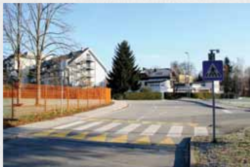
Po izvedbi ukrepa
